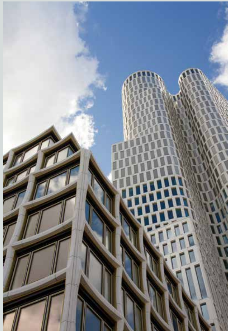
Die geschwungene Außenfassade des »Upper West« ist das neue Wahrzeichen in der City West in Berlin.
